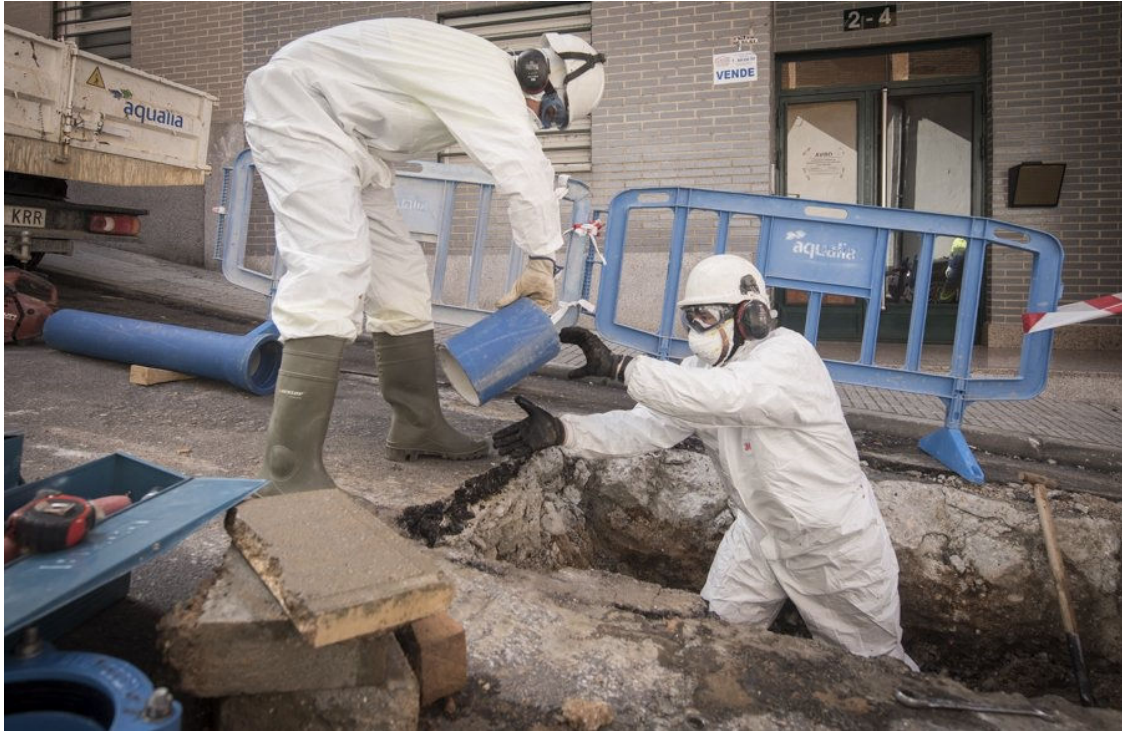
Servicios de Aqualia de tratamientos de agua de Salamanca Foto: González-Cebrián
